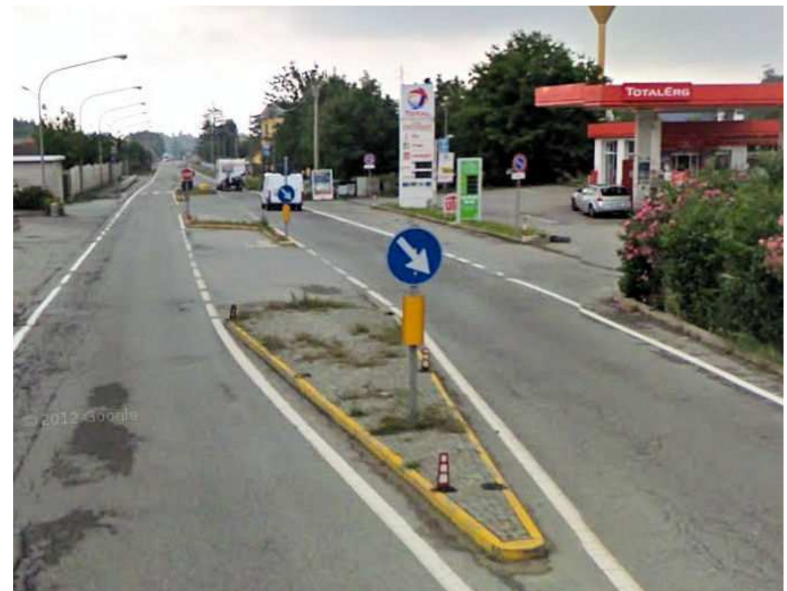
Strada provinciale con immissioni laterali protette con canalizzazioni rigide
