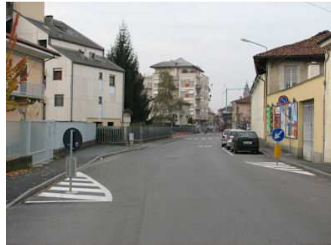
Esempio di chicane attuata con parcheggi alternati (in nuova Zona 30 in Piemonte)
