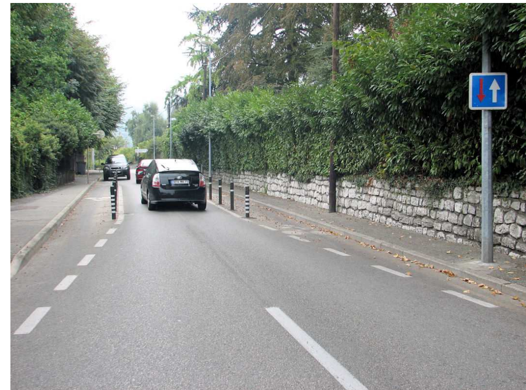
Esempio di senso unico alternato "imposto" a Chambéry (con ciclabili ai lati)
