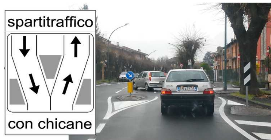
Esempio di tratta stradale gestita con serie di chicane
