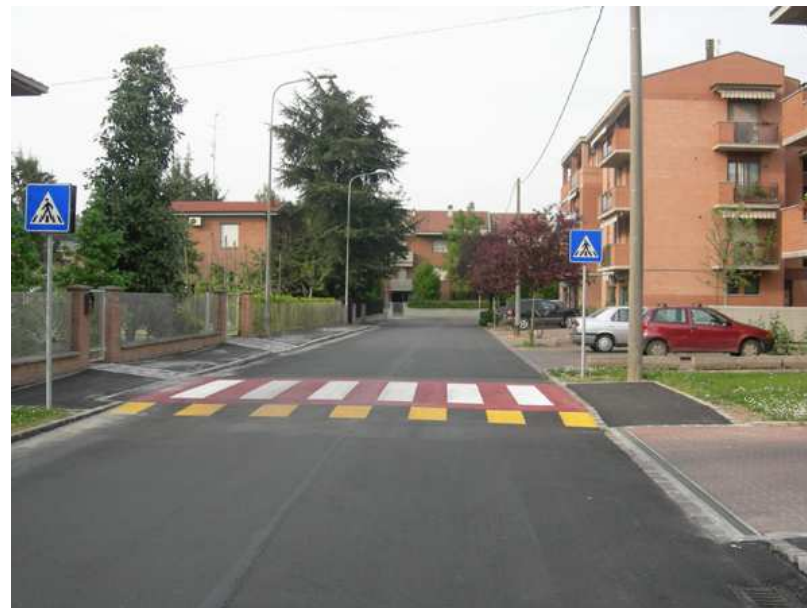
Passaggio rialzato in asfalto
