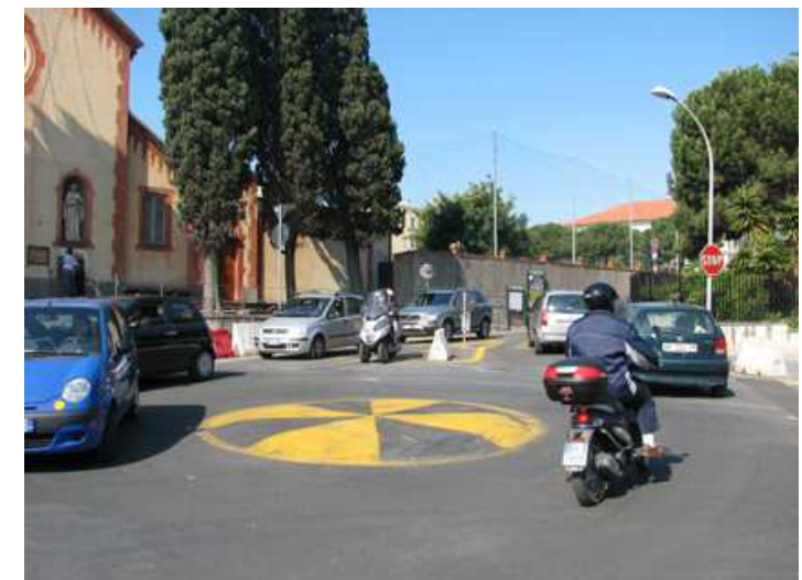
Minirotonda provvisoria per verifica funzionale
