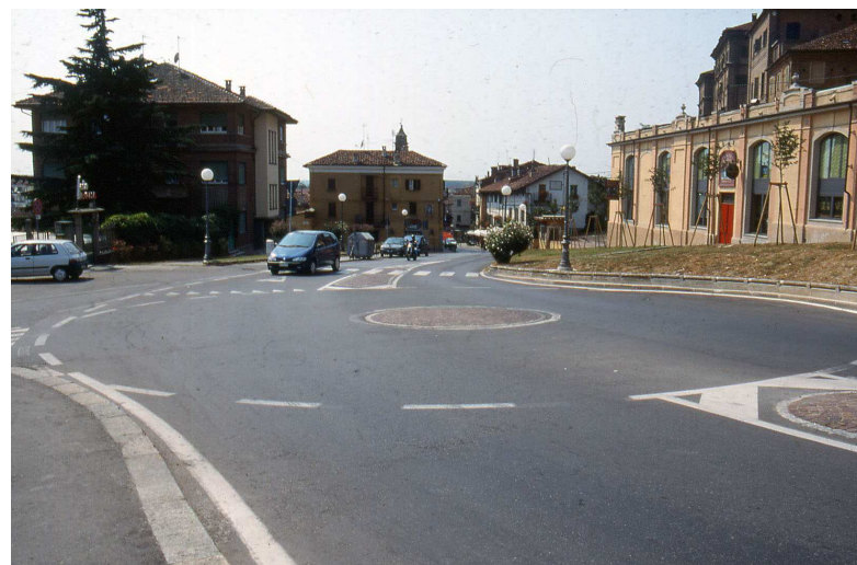
La prima minirotonda in Italia realizzata a Fossano
