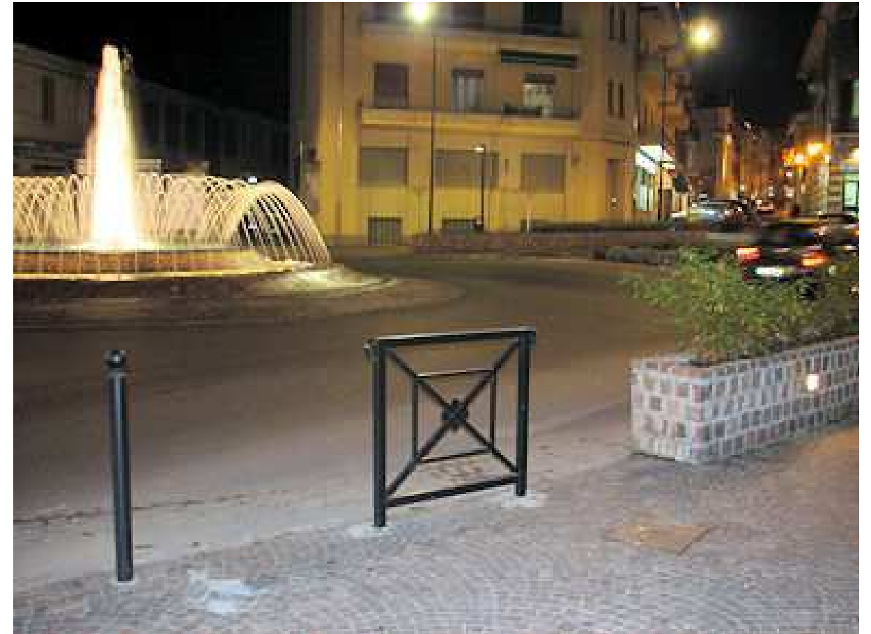
Esempio di protezione mediante l'integrazione di paletti, barriere e muretti rivestiti in pietra
