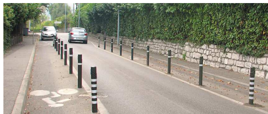
Esempio con senso unico alternato con ciclabile laterale
