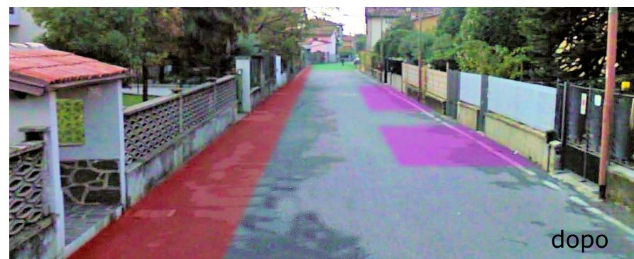
Via Daminelli La strada, prevista con senso unico verso il centro, viene strutturata con un percorso pedonale protetto e l'alternanza di stali di sosta
