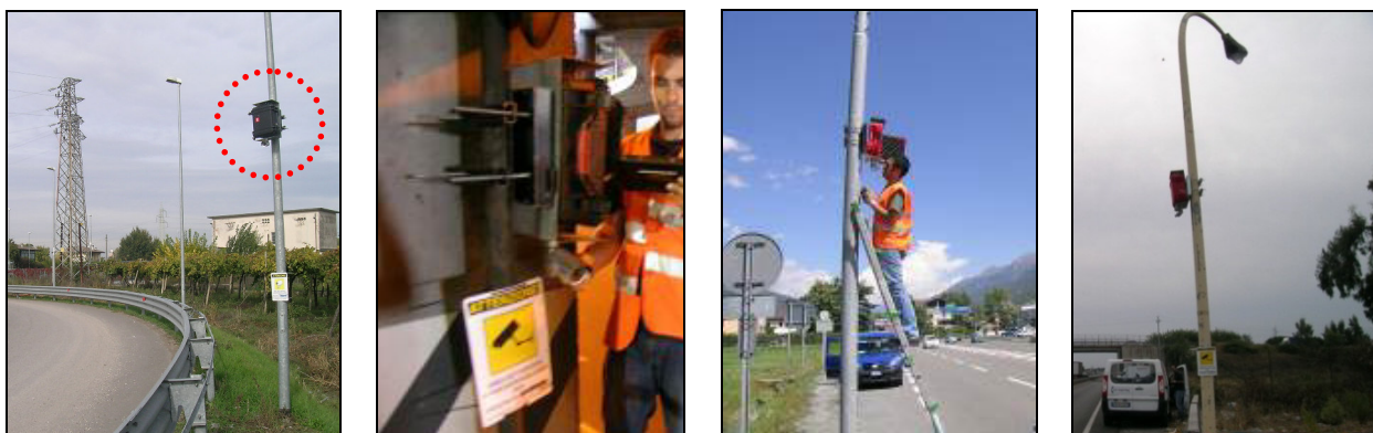
Figura 3 – Esempi di posizionamento delle telecamere ad infrarossi
